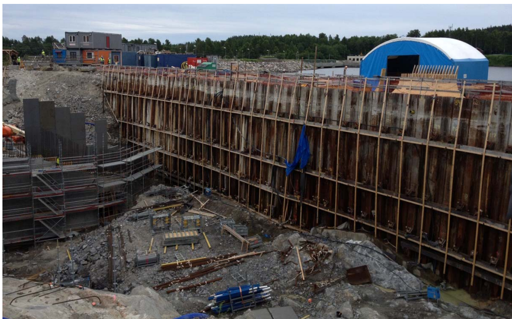
Figur 2. Bild på spont i fångdamm i Bergforsen. Bild tagen från vänster ledmur
