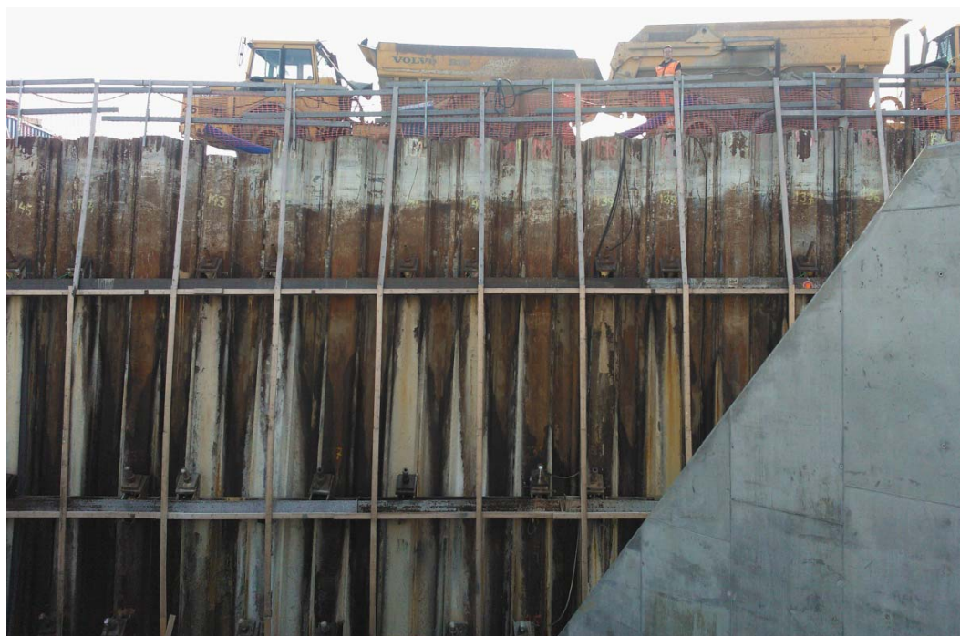
Figur 4. Olastade dumptrar uppställda intill spanten, A25 till vänster och A35 till höger. Till höger syns början på höger ledmur.
