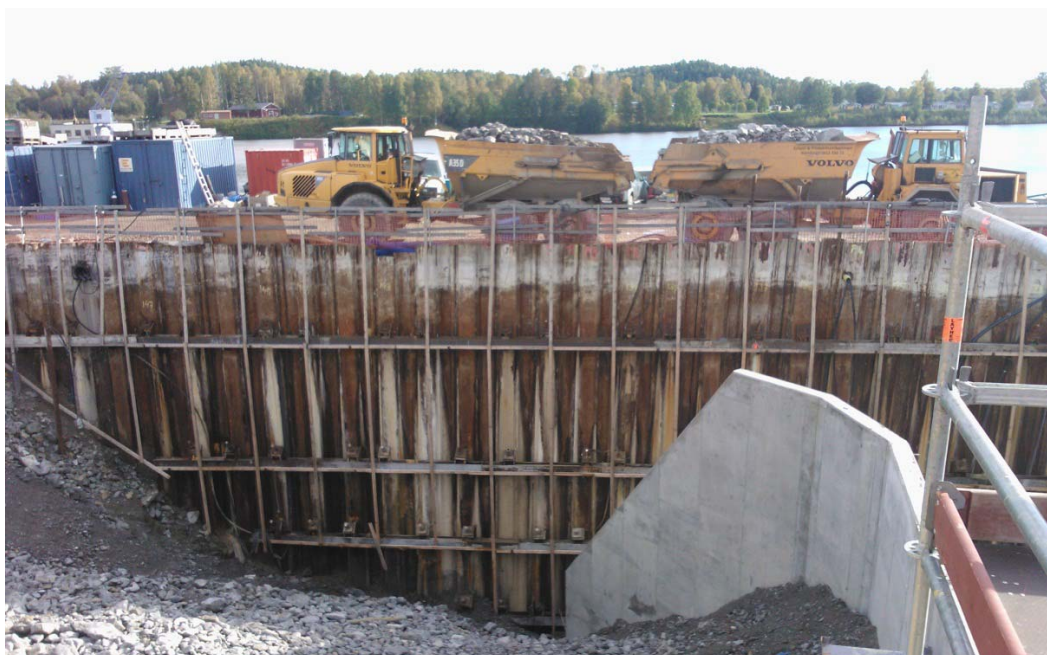
Figur 6. Lastade dumprar uppställda intill sponten, 2 st A35-or.
